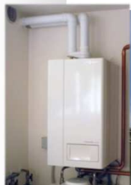
CALDAIA a SERVIZIO DELL'IMPIANTO DI RISCALDAMENTO
