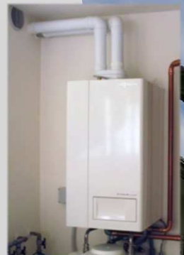
CALDAIA A SERVIZIO DELL'IMPIANTO DI RISCALDAMENTO
